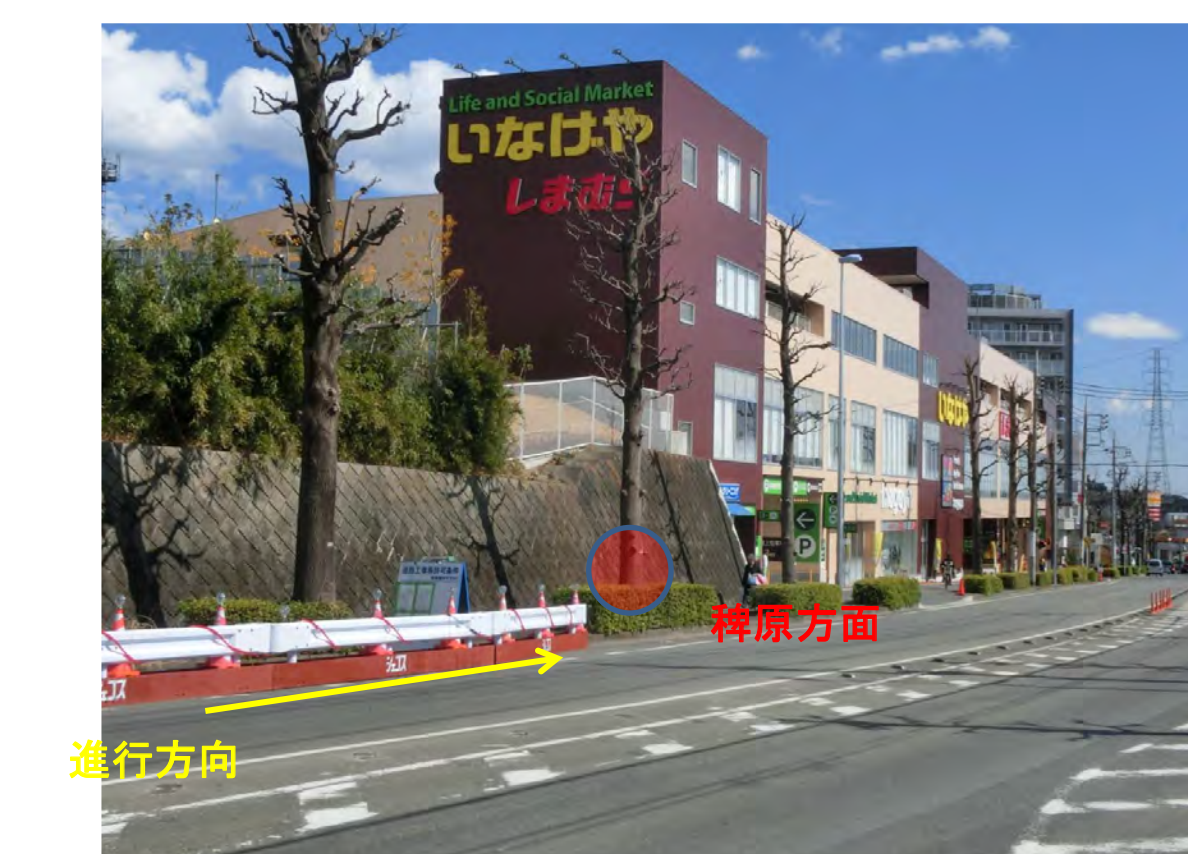
⑨いなげや手前(田園調布大前 工事中につき)
