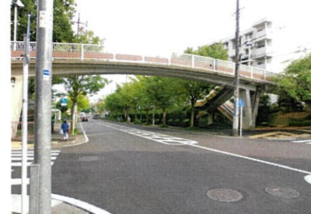
④あざみ野団地 歩道橋下
